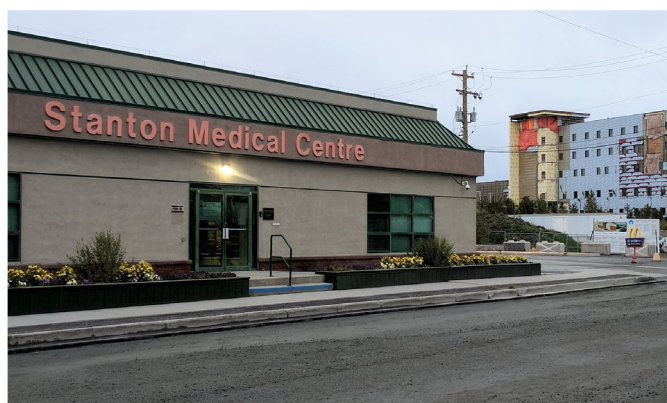
Le centre médical de Stanton et le tout nouveau centre hospitalier en construction (en arrière-plan).
